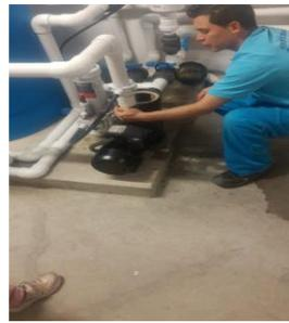
**Mantenimiento correctivo realizado a los equipos de Piscina:** por daño grave – ruptura del filtro con el que se recibió todo el sistema de caldera, hubo que realizar el cambio de dicho filtro de arena, esto se dio el día 19 de octubre del 2022.
