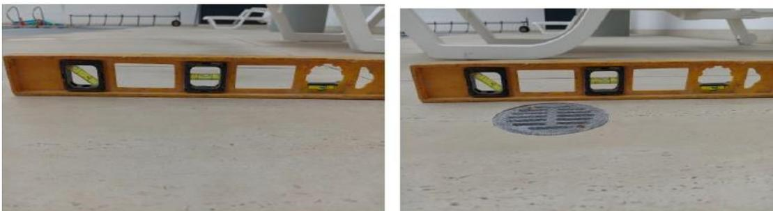
Las trece (13) rejillas instaladas en la piscina no tienen el desnivel que permita la evacuación del agua
